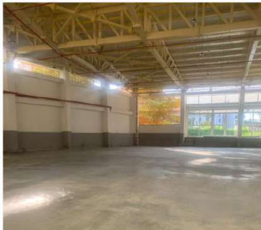
Red contra incendio coliseo de gimnasia
