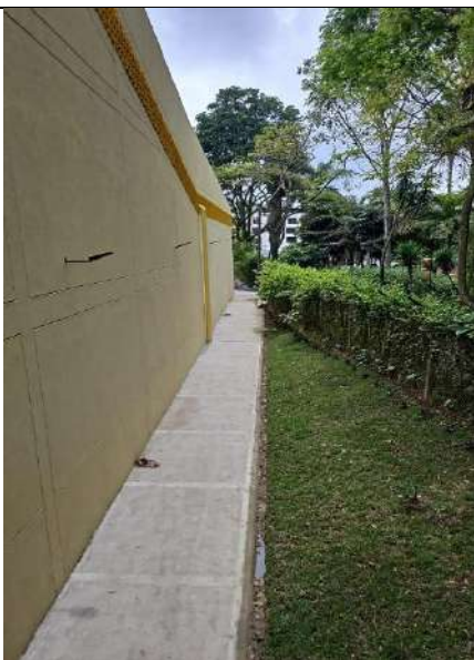
Rampa de acceso para personas con movilidad reducida
