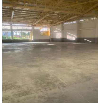
Estructura de la cubierta metálica con correas
