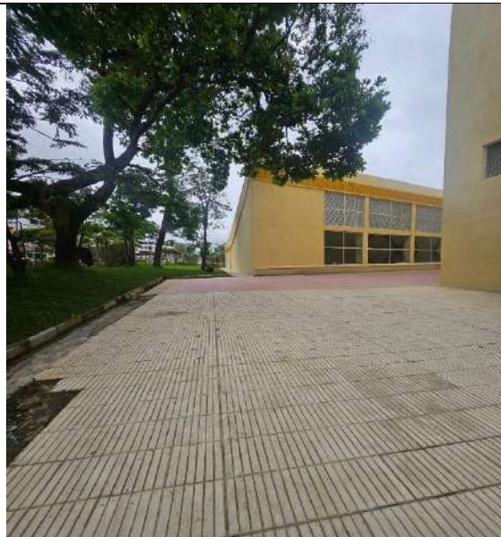
Pasillo entre la fachada de coliseo menor y de gimnasia
