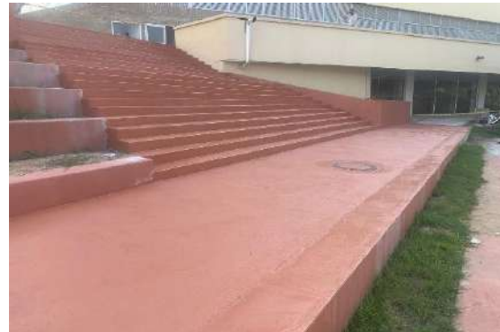
Acceso por el costado de la plataforma
