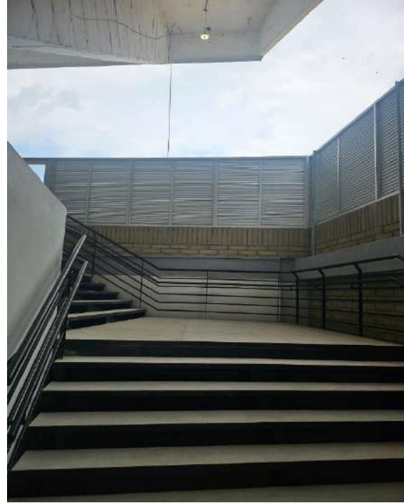
Escaleras para ingresar al mezzanine
