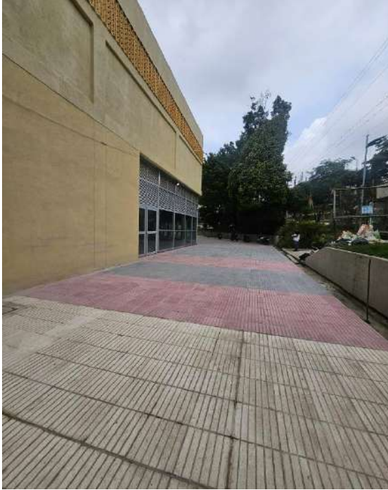
Acceso por el costado de la 5
