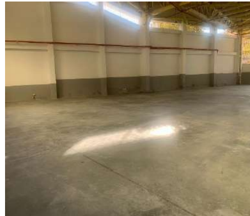
Pañete impermeabilizado y pintura en muro
